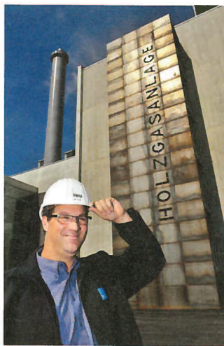
Nach Plan: Kraftwerksleiter Matthias Vizek will im Oktober den Probetrieb starten.
