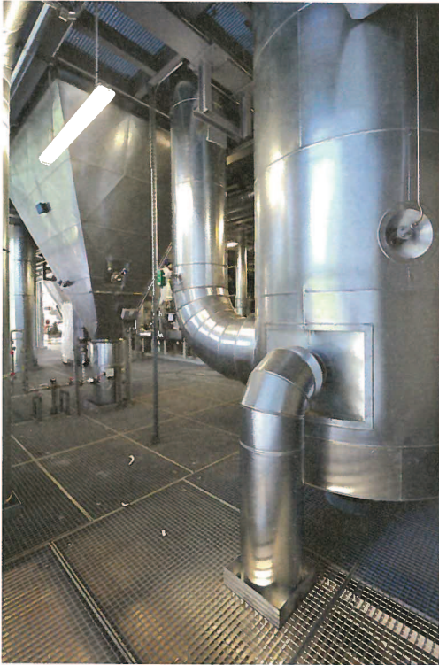
Vor der Premiere: Noch laufen letzte Wartungsarbeiten, bald sollen im Vergaser (links) Holzhackschnitzel verarbeitet werden.
