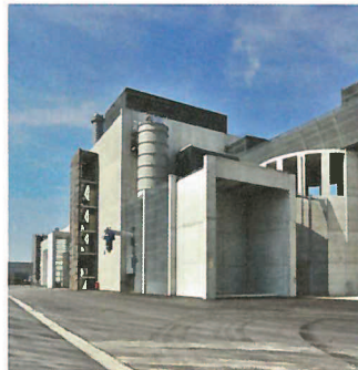
Viel Holz: 44 000 Tonnen Holz braucht das Kraftwerk Senden pro Jahr.
